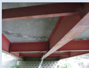
H形桁橋(東永橋)
