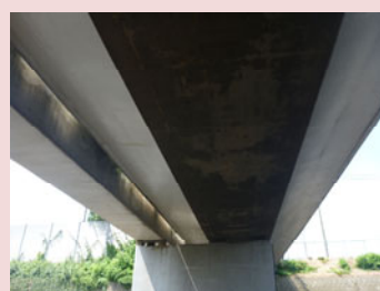
床版橋(中東1号橋)
