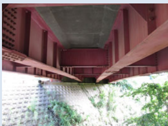
鈹桁橋(東永二橋)
