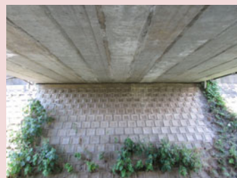
床版橋(坂下橋)
