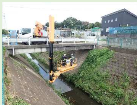
橋梁点検車による点検(永久保六橋)
