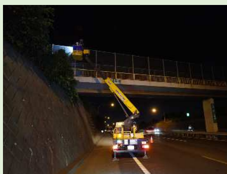
リフト車による点検(中東四号橋)
