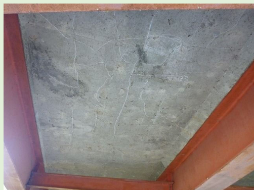
床版の補修、塗装の塗替え(東永橋)
