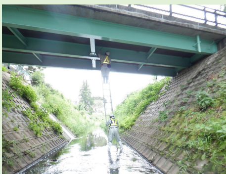
梯子による点検(東永橋)
