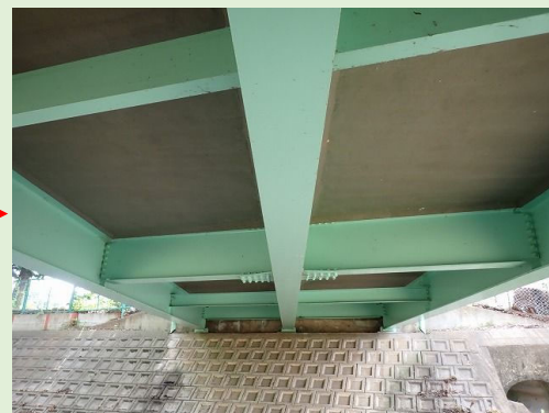
床版の補修、塗装の塗替え(東永橋)
