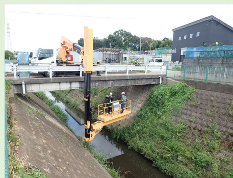
橋梁点検車による点検(永久保六橋)
