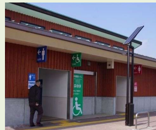
非常用電源付きトイレ 道の駅旭志 (菊池市)
