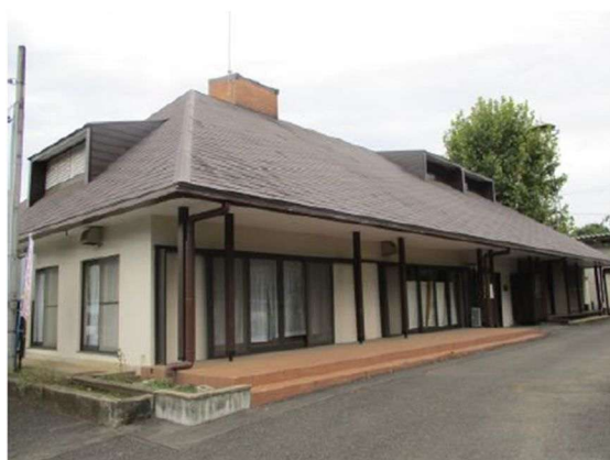
(写真) 農業センター
