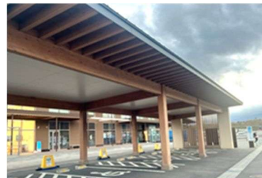
屋根付きバリアフリー駐車場 道の駅ふくしま(福島県福島市)
