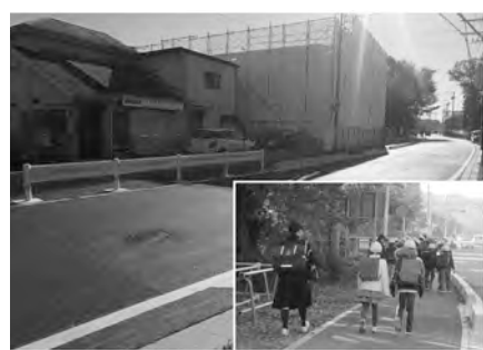
工事が完了した第二保育所周辺の歩道
