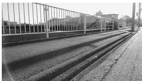
唐沢小学校前のマウントアップ歩道
