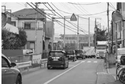
三芳スマートICへのアクセス道路 大型車がすれ違いできない箇所も
