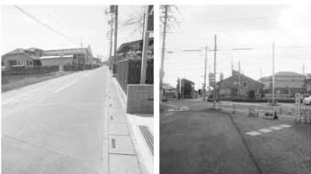
変則な交差点になることが予想され、十分な安全対策が今後の課題 歩行者が通行するスペースがなく危険!幅員の拡幅、歩道整備が必要な幹線15号線
