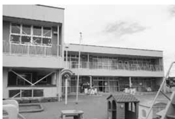
平成25年に改築された町立第2保育所
