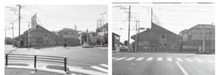
国道 254 号線、幹線 19 号線を結ぶ交差点の整備が完了。心配される今後の安全対策。
