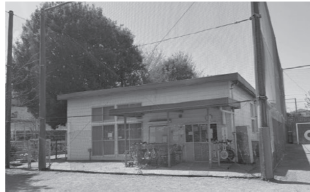
令和6年度中に解体予定の藤久保第1学童保育室
