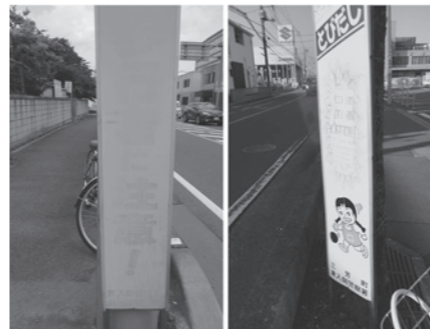
経年劣化した看板
