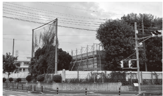
藤久保地域拠点施設の工事が始まった藤久保小学校
