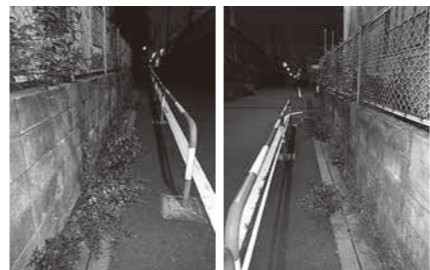
通行の妨げになる歩道内の伸びた雑草
