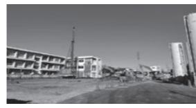
工事中の藤久保小学校
