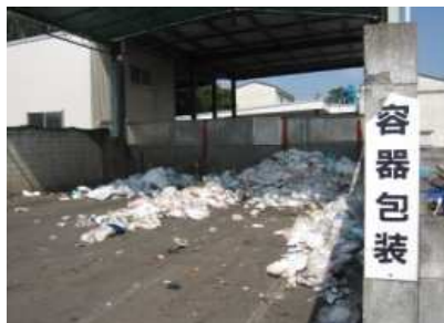
清掃工場ストックヤード
