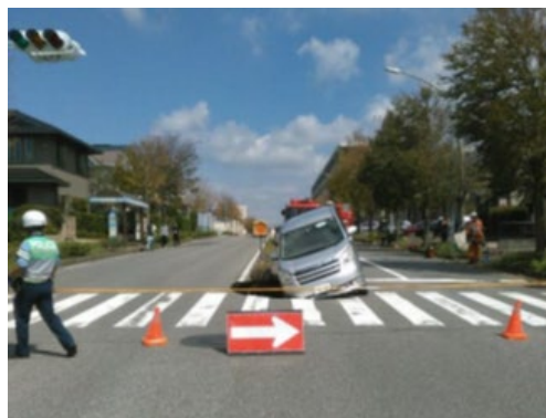
写真 2-1 道路陥没の様子
