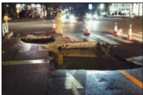
写真 2-1 道路陥没の様子
