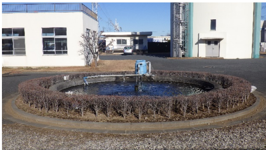
原水水質監視池
