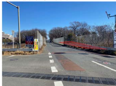
③ 歩道橋設置予定箇所
