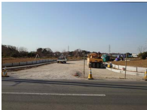
① 町道付替道路工事 (町道上富69号線)
