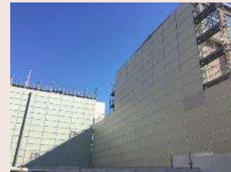
防音パネルの設置
