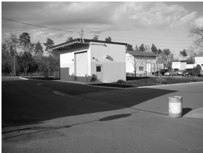
▲三芳町清掃工場ストックヤード
