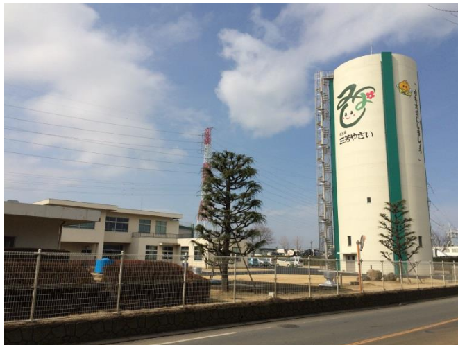
■浄水場配水塔
