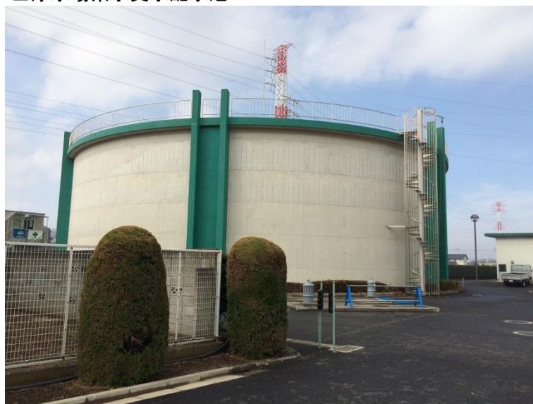
■浄水場県水受水配水池
