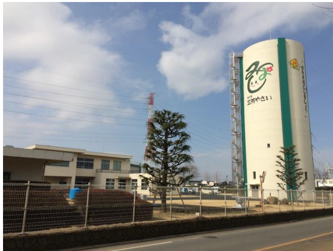
■浄水場配水塔
