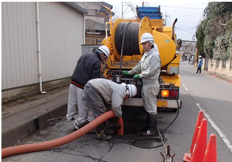
■ 雨水貯留施設清掃
