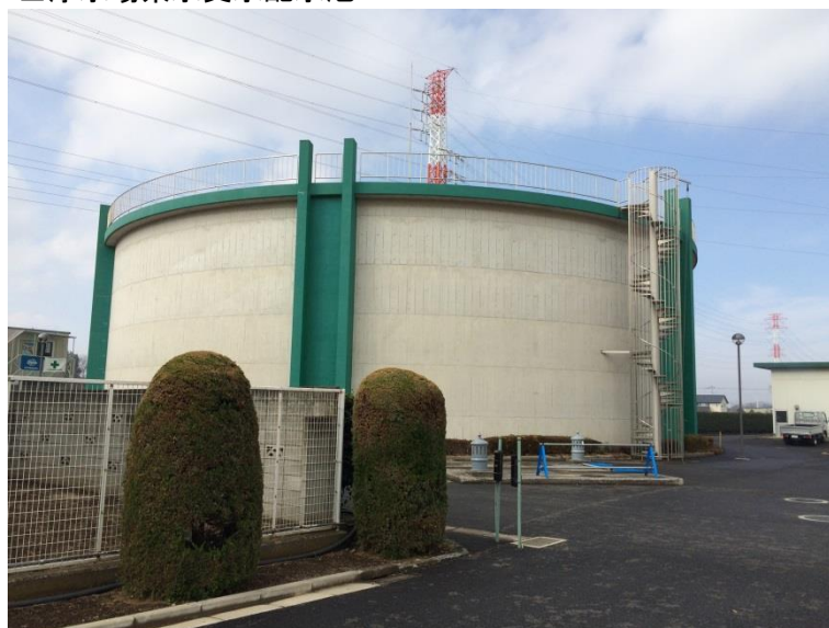
■浄水場県水受水配水池
