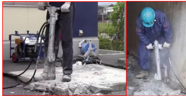
写真②：ハンドブレイカーによる解体 ※参考写真
