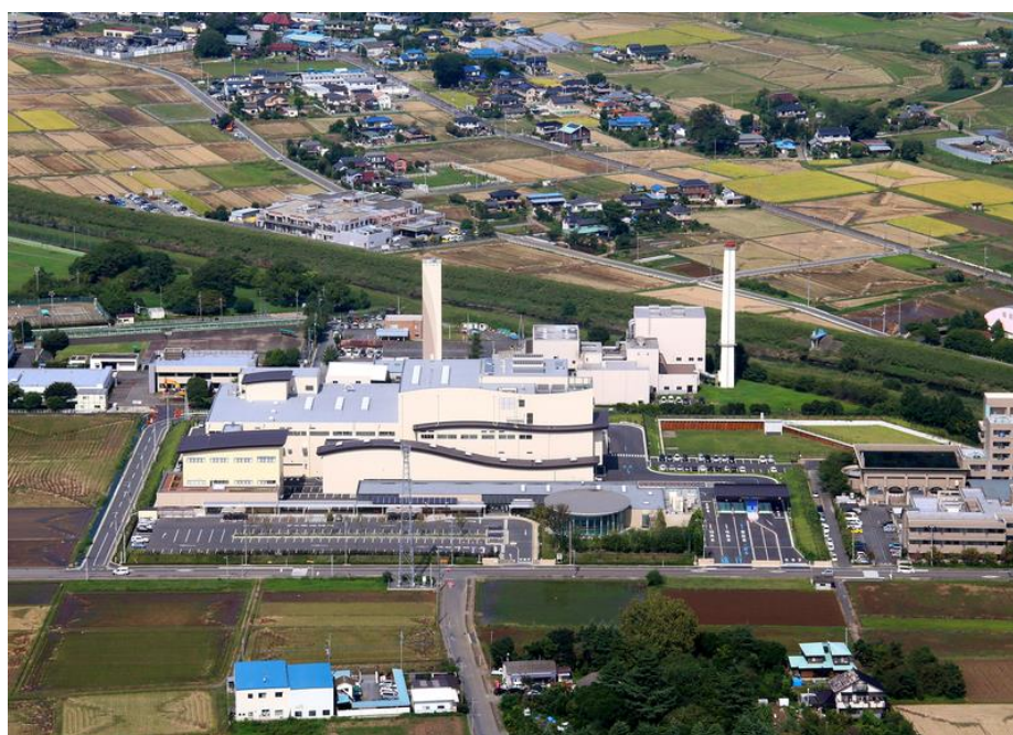
図 3-2 ふじみ野市・三芳町環境センター
