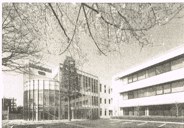
ダイダン(株)開発技術本部外観 三芳町北永井(本社:大阪市)
