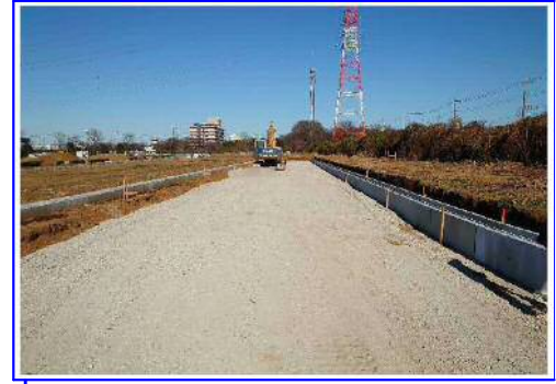
付替工事 施工中（令和3年4月）
