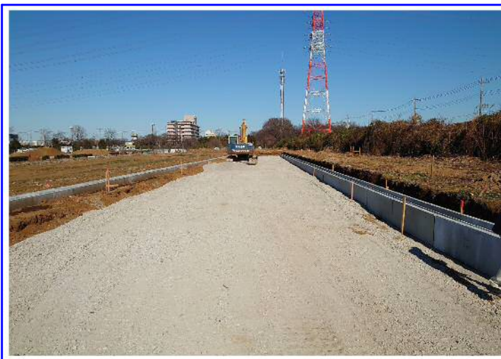
付替工事 施工中（令和3年4月）
