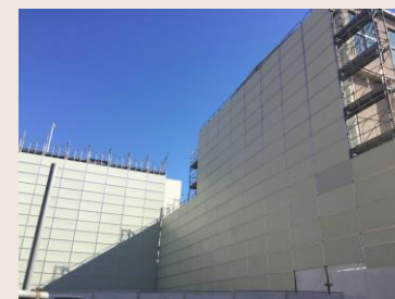
防音パネルの設置
