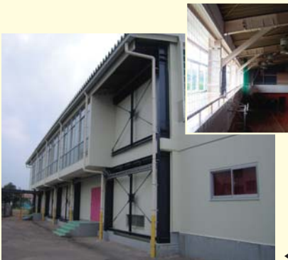
▲昨年度、耐震補強工事が終了した唐沢小学校体育館
