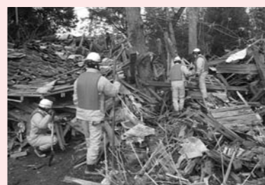
倒壊した家屋で人命検索を行う隊員 (岩手県陸前高田市)
