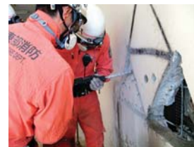
救助資機材でコンクリート壁に救出用の穴を開ける隊員
