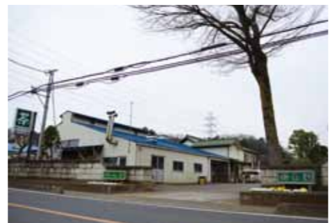
鈴木園の外観。多福寺から大井方面に進んだ県道56号線沿いにあります。
