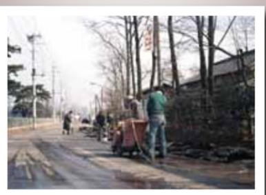
写真は昭和45年に撮影された三芳中学校前の水道管布設工事の風景。昭和42年に舗装されたアスファルトを切って水道管の布設工事を行っています。昭和44年に村営水道の初給水がされて以降、全域給水に向け村内各地で工事が行われてきました。水道を使い慣れていない人も多い時代。昭和46年1月号の広報には水道管凍結予防の記事が掲載されています。
