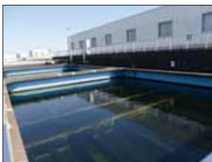
沈でん池で小さなかたまりを沈めて取り除いた後、急速ろ過池に運び、水中のにごりを砂と砂利の層を通して取り除きます。
