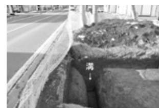
↑溝は道路と並行するように掘られていた
