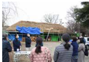
↑ 13年ぶりに行われている旧島田家住宅の差し茅工事。
