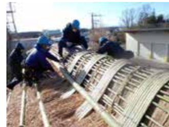
▲茅束、トタン板、杉皮、竹すのこの順に被せ、全てを割竹で押さえるグシの仕上げ作業。
