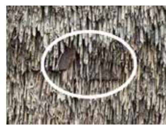
▲軒先近くの茅の中に、挟み込まれた杉皮の一部が見える (白丸部分)。
