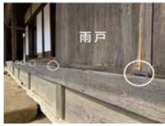
▲鉄の金具がしっかりと取り付けられ(白丸部分)、侵入者は簡単に雨戸を外せません
