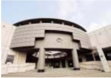
● コピスみよしエントランス Entrance of Coppice Miyoshi
