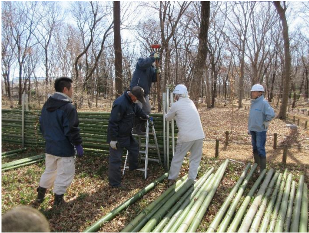
パイプの打ち込み
